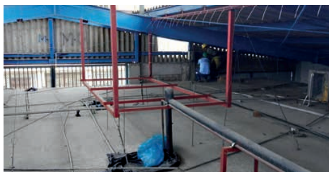
Figura 10. Instalación de prototipos en Callao. Fuente: Elaboración propia.
